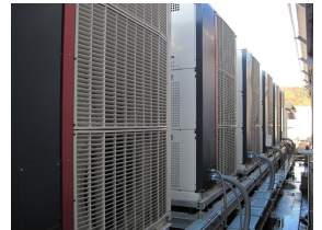
ヒートポンプチラー 高効率に館内の空調をコントロールします
